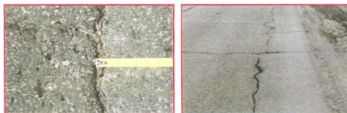
Rasm 6.2. Qoplamada ishlov berilmagan yoriqlarning ko‘rinishi.
