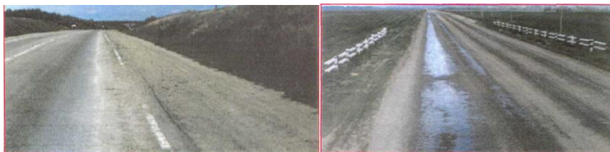
Rasm 6.1. Qoplamaning chekkasida va bitumni terlash uchun ishlov berilmagan joylarda ifloslanish chiziqlar mavjudligi
