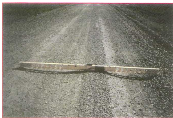
Rasm 6.4. O'tuvchi turdagi qoplamalardagi g'ildirak izi
