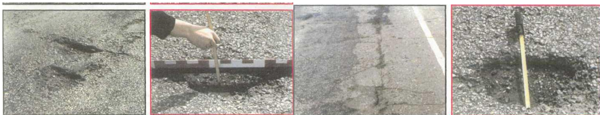
Rasm 6.3. 15 \times 60 \times 5 sm (uzunligi \times kengligi \times chuqurligi) dan oshmaydigan shikastlanishlar (teshiklar) ko'prik yo'liga ham tegishlidir.
