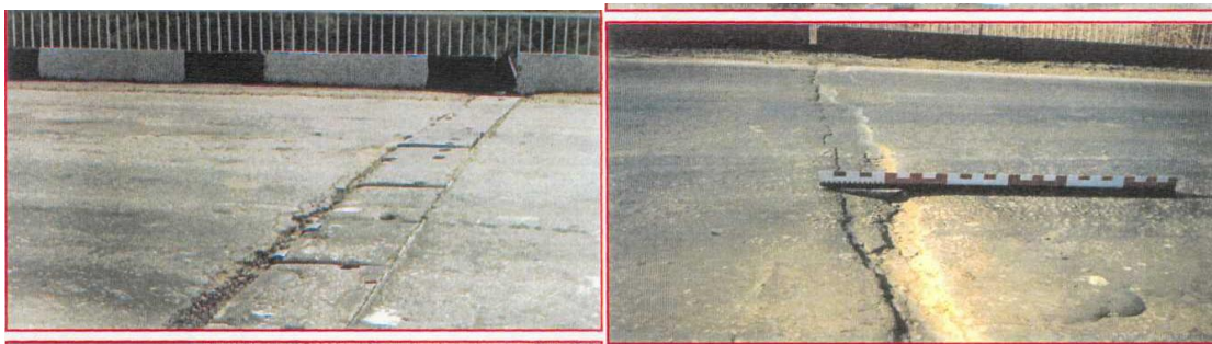
Rasm 6.12. Kengayish bo'g'implari bo'ylab yulka qatlamlarini lokal ravishda yo'q qilish, mastik chipslari
