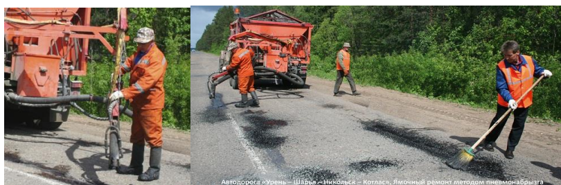
Rasm 6.42. Sovuq in'ektsiya teshiklarini muhrlash texnologiyasi
