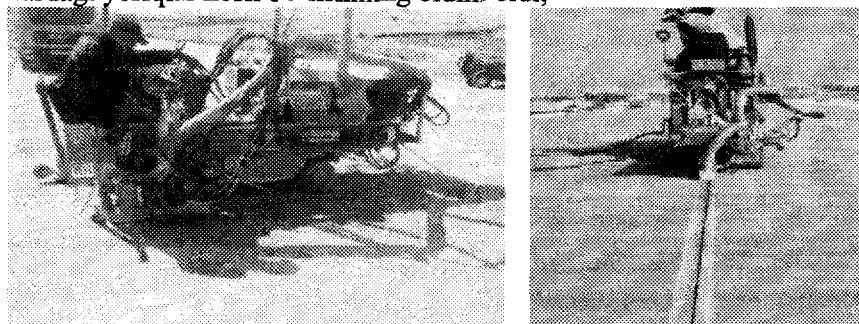
4.30-rasm. Ko'ndalang va bo'ylama choklarning ochilishi
