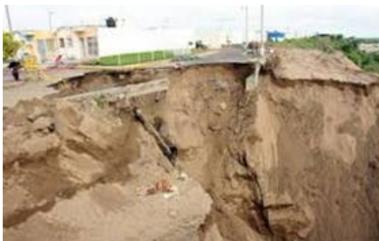
118-rasm. Jarliklarning muhandislik inshootlariga ta'siri
