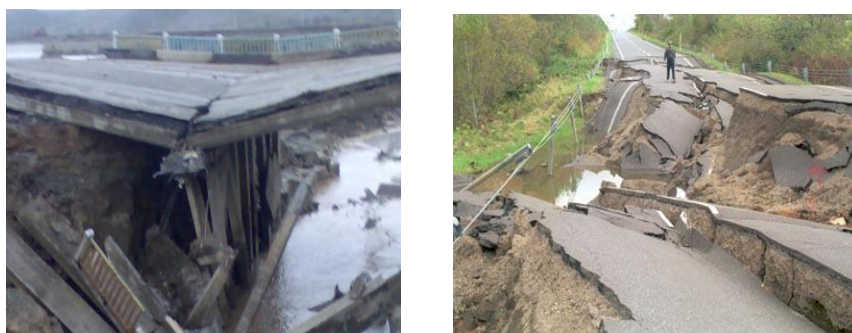
88-rasm. Cho'kish jarayoni natijasida inshootlarning buzilish holatlari
