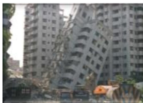
151-rasm. Tektonik zilzilaning muhandislik inshootlariga ta'siri
