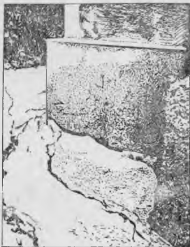
IV. 5- расм. Грунтнинг пойдевор остида ситилиб чиқиши.
