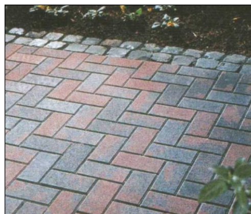
3.42-расм. Магистраль қопламаларини плиткалардан териш
