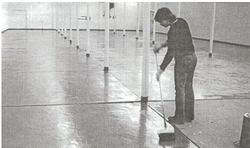
3.17-расм. Эпол эпоксидли-сланецли қуйма полларни карталар бўйича қуриш
