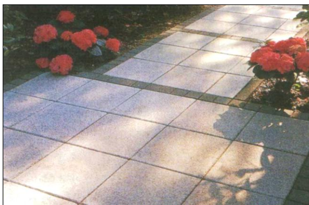
3.41-расм. Мавзе ичкарасидаги йўллар қопламаларини плиткалардан териш
