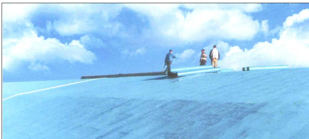
3.14-расм.. Тез барпо қилинувчи бионинг Алькоплан мембранасидан қурилган том қопламаси
