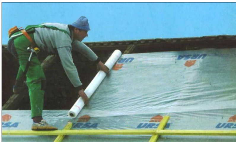
3.15-расм. "Урса-секо 500" асосидаги буғ-изоляцияси
