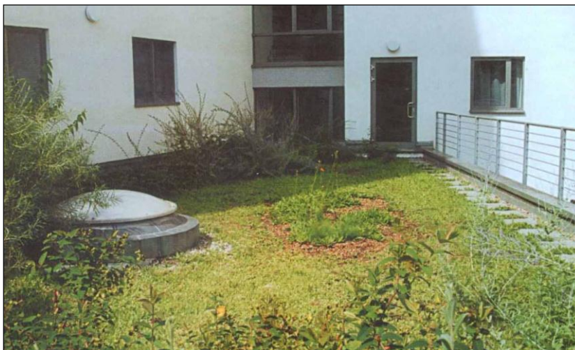
3.16-расм. Кўкаламзорлаштирилган том қопламаси
