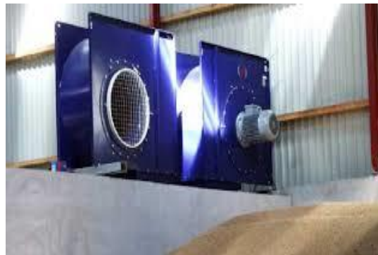
5.5-расм. Сақлаш омборларида донларни фаол шамоллатиш
