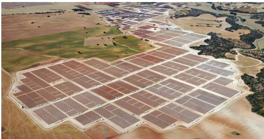
4.12-rasm.Dunyodagi eng katta fotoelektrik elektrstansiyasi.
