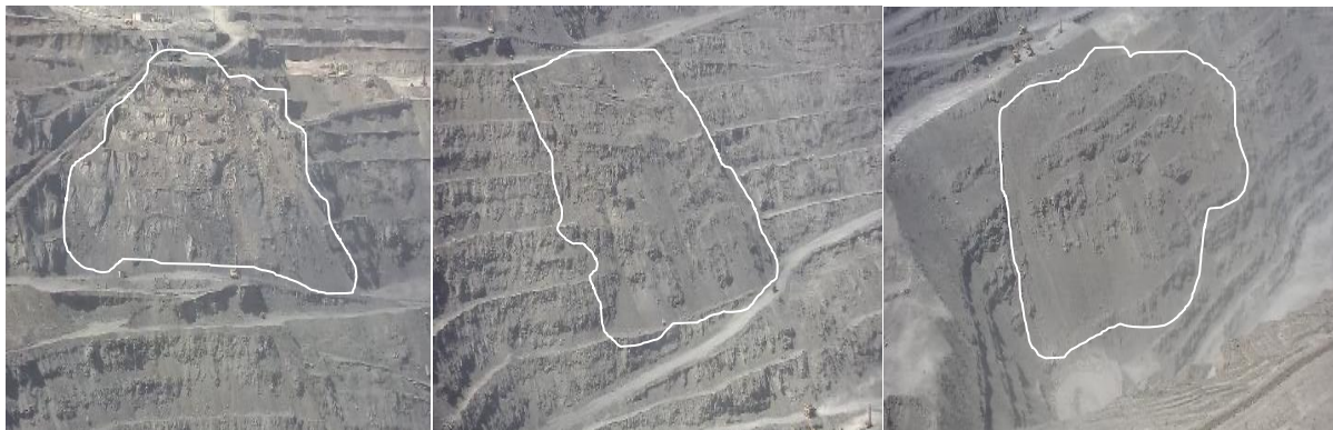
Рис. Южный борт карьера Мурунтау. Развития деформации, нарушение берм и образование сплошных откосов
