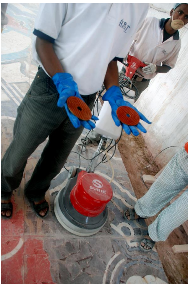
14л-расм. Флоренция мозаикасини махсус аппарат билан силлиқлаб пардозлаш.
