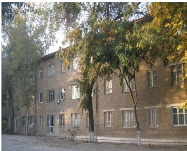
2.11 – расм. Девори пишган ғишдан 3 қаватли наъмунали турар – жой бинолари. (Қурилган йили 1950 й. Ора ёпмасы – йиғма, антисейсмий тасмалар ва ўзак мавжуд эмас)
