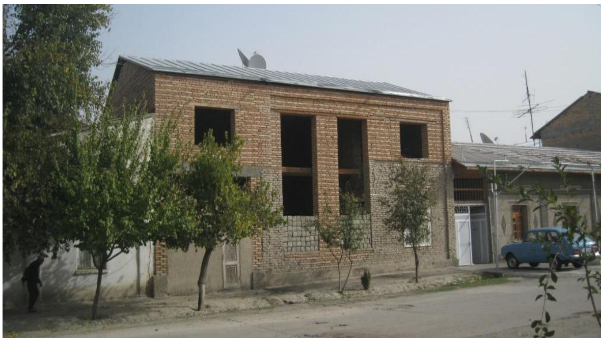
2.8 – расм. Биринчи қават девори хом ғиштдан, иккинчи қават девори пишган ғиштдан қурилган икки қаватли маҳаллий турар – жой биноси. (2009 йил қурилган, антисейсмик тасма ва ўзаклар мавжуд эмас).
