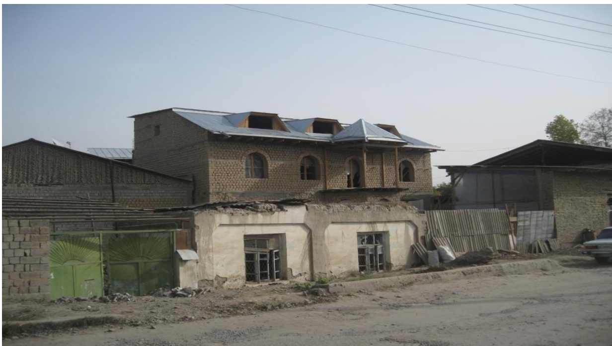
2.6 – расм. Девори лойли (хом) блок ғиштдан қурилган 2 қаватли маҳаллий турар – жой биноси (2009 йил қурилган; антисейсмик тасмалар мавжуд, ўзаклари мавжуд эмас).
