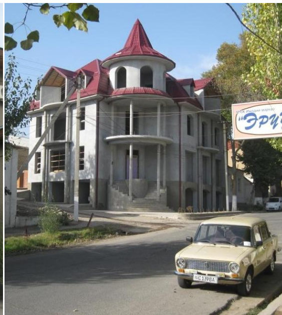
2.9 – расм. Девори пишган ғиштдан комплекс конструкцияли, 2 қаватли цоколь ҳамда мансарли қурилган, ертўласи бор турар – жой биноси. (2007 – 2009 йилларда қурилган, антисейсмик тасма ва ўзаклари мавжуд).
