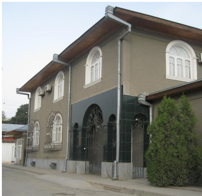
2.9 – расм. Девори пишган ғиштдан комплекс конструкцияли, 2 қаватли цоколь ҳамда мансарли қурилган, ертўласи бор турар – жой биноси. (2007 – 2009 йилларда қурилган, антисейсмик тасма ва ўзаклари мавжуд).
