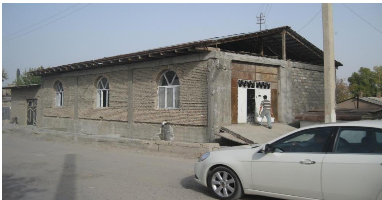
2.7 – расм. Деворлари хом ғиштдан, ер тўлали бир қаватли маҳаллий турар – жой биноси (2009 – 2010 йилларда қурилган, антисейсмик тасма ва ўзаклари мавжуд)
