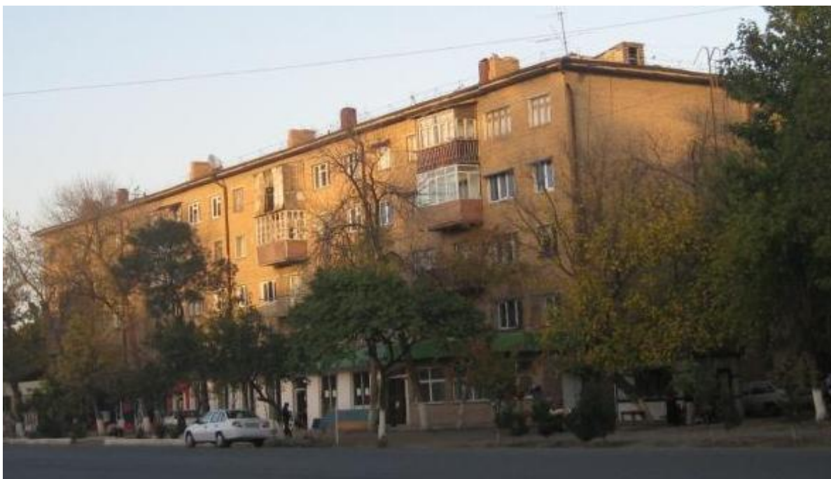
2.13 – расм. Деворлари пиширилган ғиштдан наъмунали 5 қаватли турар – жой бинолари (1950 – 1960 йилларда қурилган, ора ёпмаси йиғма, антисейсмик тасмалари мавжуд, ўзаклар мавжуд эмас)
