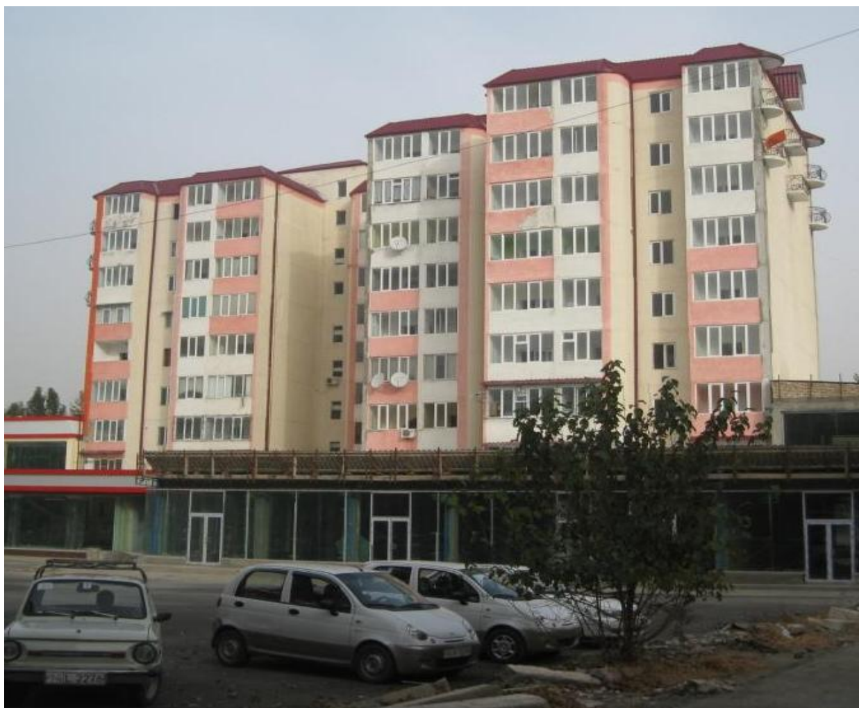
2.19 – расм. Яхлит темирбетон асосида 9 қаватли 3 секцияли турар – жой биноси (2007 йил қурилган, зилзилабардошлиги – 8 балл, А.Темур кўчаси)
