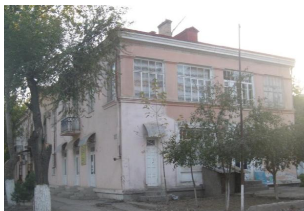
2.10 – расм. Девори пишган ғишдан 2 қаватли турар – жой бинолари. (Қурилган йили 1950 й. Ора ёпмасы – йиғма темирбетон ва яхлит, антисейсмий тасмалар ва ўзак мавжуд эмас)
