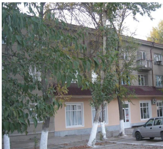
2.11 – расм. Девори пишган ғишдан 3 қаватли наъмунали турар – жой бинолари. (Қурилган йили 1950 й. Ора ёпмасы – йиғма, антисейсмий тасмалар ва ўзак мавжуд эмас)
