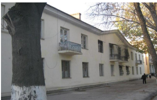
2.10 – расм. Девори пишган ғишдан 2 қаватли турар – жой бинолари. (Қурилган йили 1950 й. Ора ёпмасы – йиғма темирбетон ва яхлит, антисейсмий тасмалар ва ўзак мавжуд эмас)
