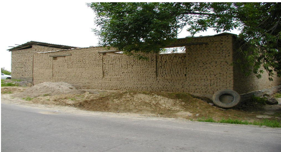
2.4 – расм. Девори хом ғиштдан қурилиб битмаган турар – жой биноси.
