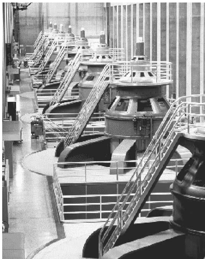
71-rasm. Hidro elektr stansiyasida gidroturbinalarining joylashishi
