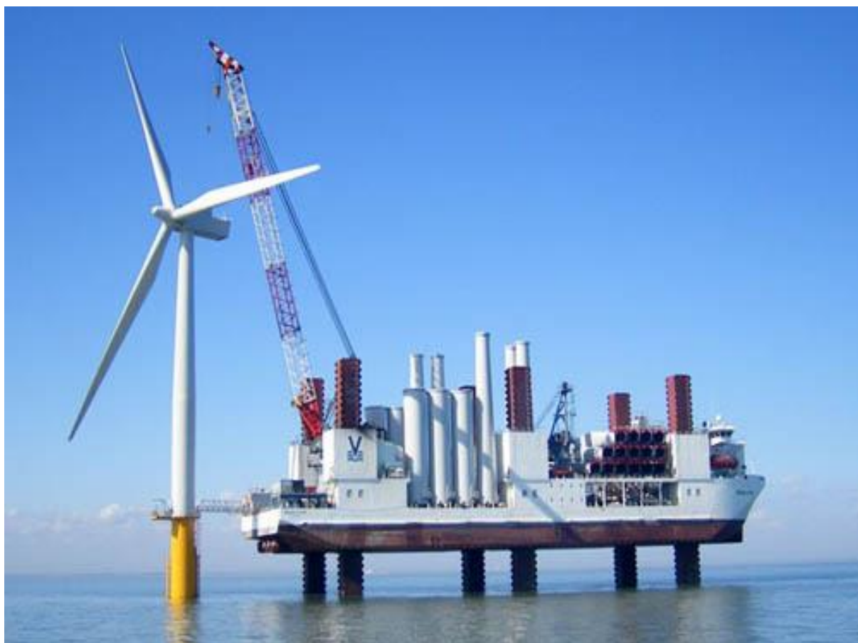
95-rasm. Eng katta quvvatli offshor shamol elektroqurilmalarini oʻrnatish
