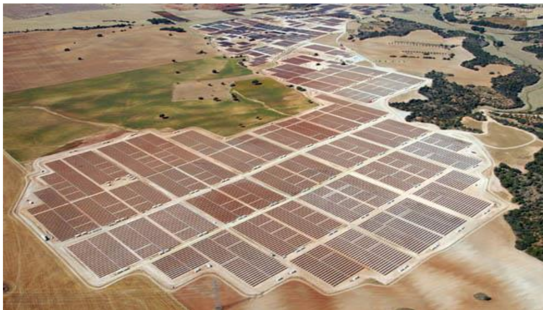
84-rasm. Dunyodagi eng katta fotoelektrik elektrostansiyasi
