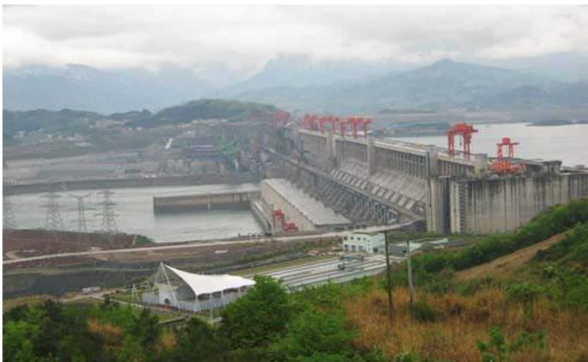
79-rasm. Uch dara gidroelektr stansiya, quvvatli 22,4 GVt (Xitoy)
