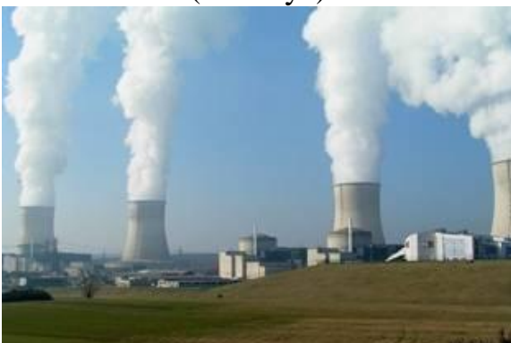
60-rasm. Kattnom atom elektr stansiyasi (Fransiya)
