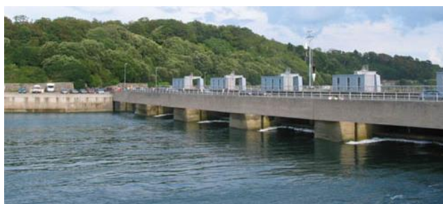
15-rasm. Suv sathining ko'tarilib-tushish prinsipi asosida ishlaydigan eng katta gidro elektr stansiyasi
