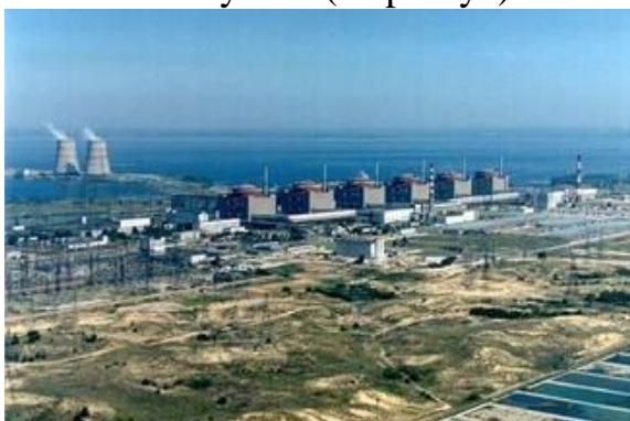
56-rasm. Zaporozj atom elektr stansiyasi (Ukraina)
