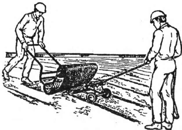
9.1-rasm. Eritiladigan ruberoid asosida tomni gidroizolatsiyalash
