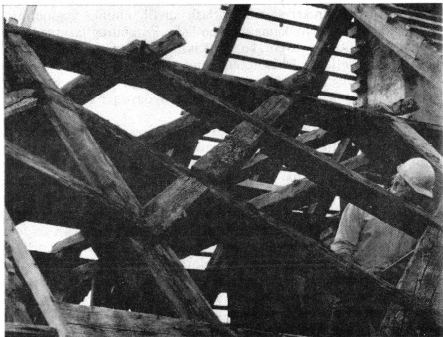
3.10-rasm. Arxitektura yodgorligining chirigan yog'och strapila qismi (GFR, Myunxen sh.).
