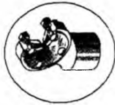
7.74-расм. Қопқоқларни конуси ичкарига қараган ҳолатда маҳкамлаш
