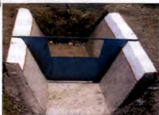
3.5-расм. Чиполетти сув ташлагичининг умумий кўриниши
