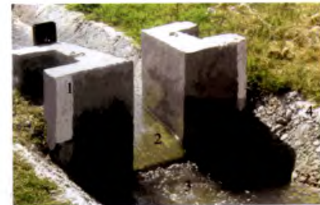
3.8-расм. САНИИРИ сув ўлчагич новининг пастки бьефдан қўриниши: 1 – новнинг пастки бьеф девори; 2 – новнинг асоси; 3 – каналнинг туби; 4 – каналнинг ён деворлари
