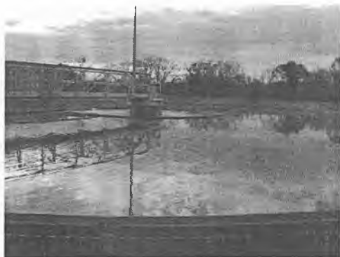
45-rasm. Radial birlamchi tindirgichlar.
