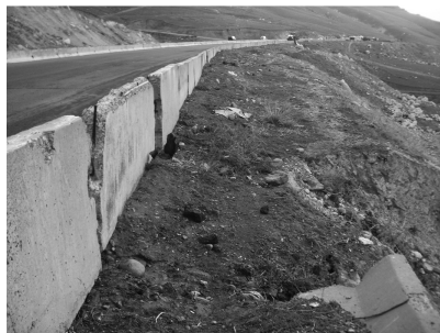
11.3-rasm. O'yma qiyalik mustahkamligining joylardagi buzilishi.
