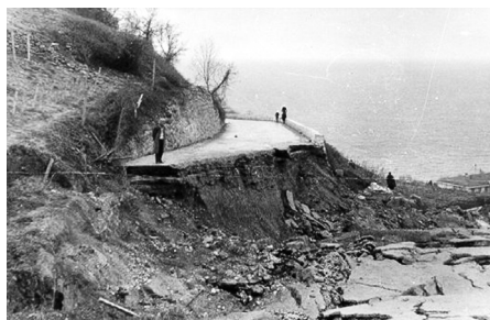
11.2-rasm. Qiyalik mustahkamligining umumiy buzilishi.
