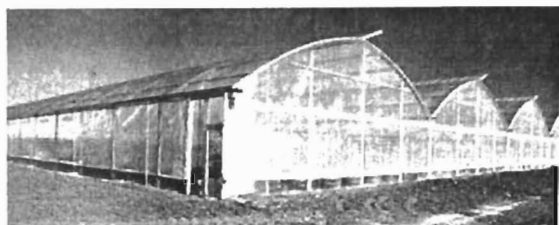
4.77-rasm. Gul o'stiradigan issiqxona bloki. Ochiq turda shamollatish tizimi
