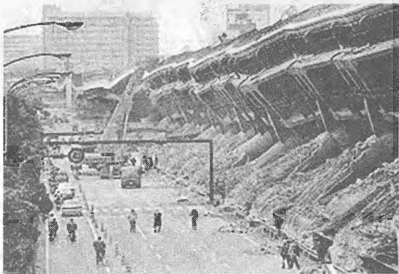
7.10-rasm. Yaponiyaning Kobe zilzilasidan qulagan yo'l o'tkazgich.
