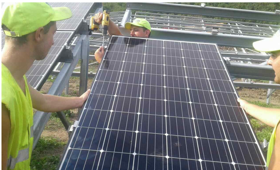
53-расм. Қуёш фотоэлектрик станциясида қуёш панелларини мухандислар томонидан ўрнатиш
