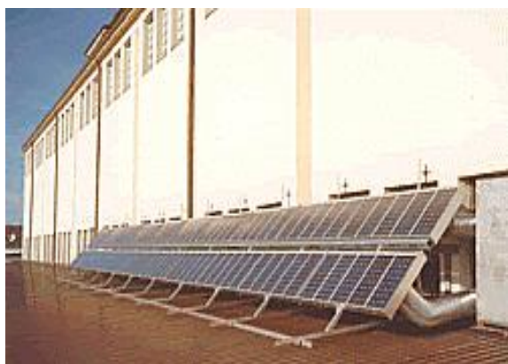
63, 64-расмлар. SolarWall компанияси томонидан яратилган ҳаво фотоиссиқлик қурилмалари
