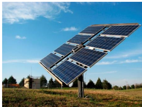
55-расм. Икки ўқли трекерга эга қуёш фотоэлектрик станцияси
