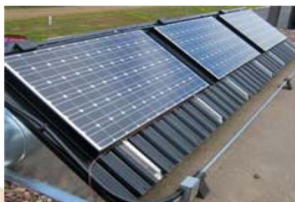
63, 64-расмлар. SolarWall компанияси томонидан яратилган ҳаво фотоиссиқлик қурилмалари
