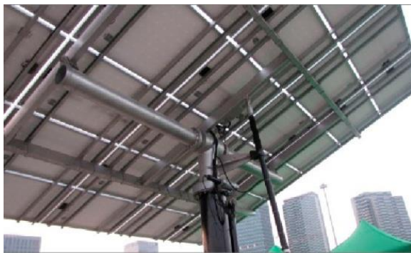
55-расм. Икки ўқли трекерга эга қуёш фотоэлектрик станцияси
