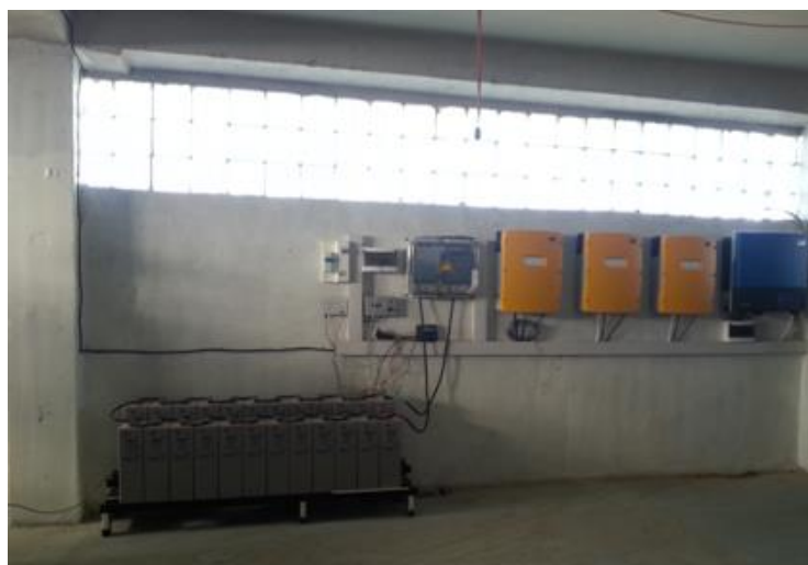
48-расм. 20 кВт қувватли ФЭС энергетик бошқарув блоки ва назорат қурилмалари
