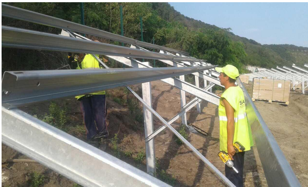
52-расм. Қуёш фотоэлектрик станциясининг каркас қисмини ўрнатиш
