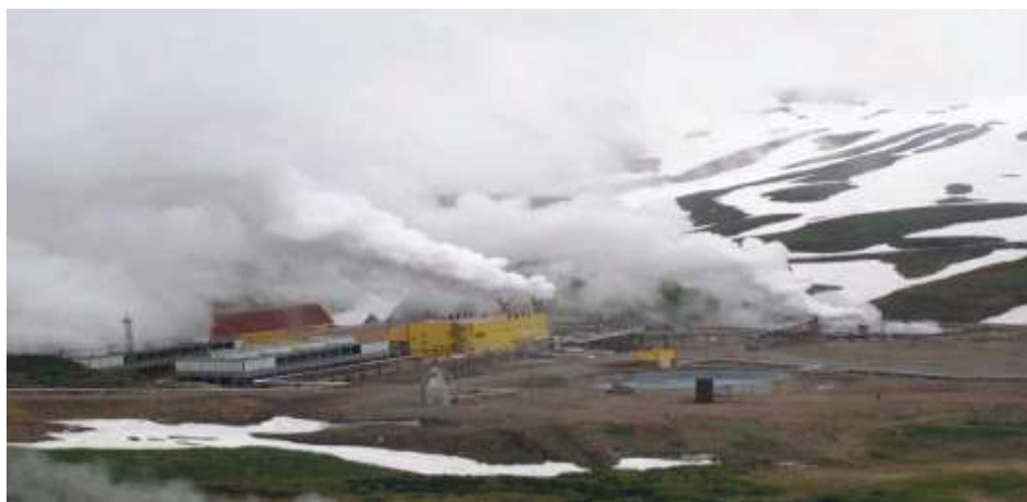
7.1.5-rasm. Rossiyaning Mutnovidagi geotermik elektr stansiya.
