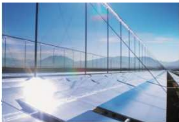
2.2.11a-rasm. Parabolik konsentratorli quyosh elektrostansiyalari.
