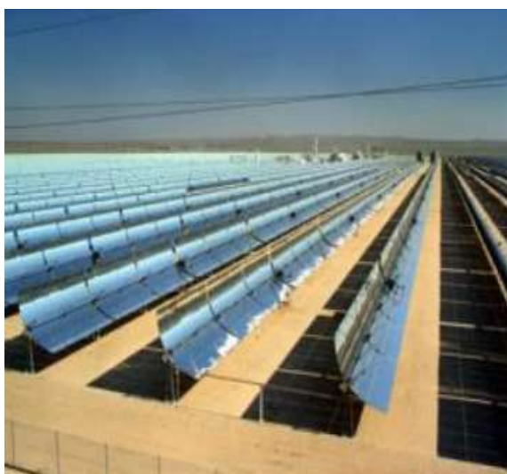
2.2.11b-rasm. Frenel konsentratorli quyosh kollektorlari.
