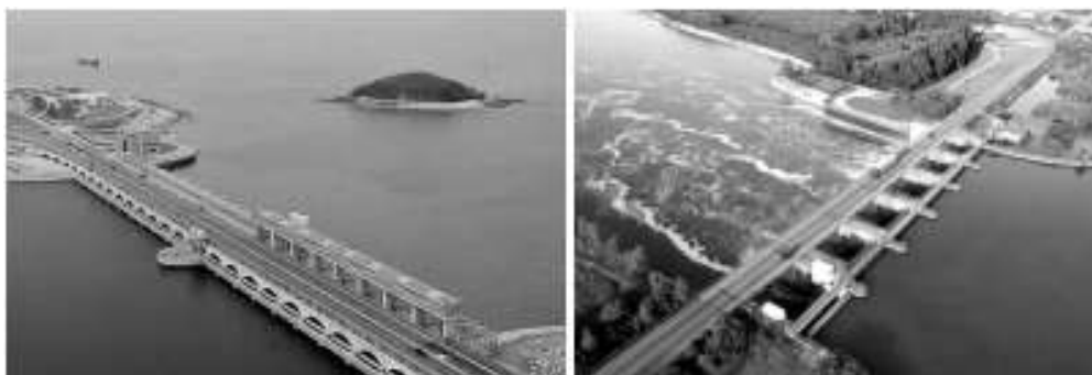
7.1.15-rasm Suvning qalqib ko'tarilishi asosida ishlaydigan elektrostansiyalar.
