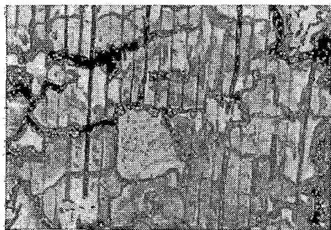
Рис. 12. Следы и остатки корродированной спиральной арматуры на внутренней поверхности снятого защитного слоя
