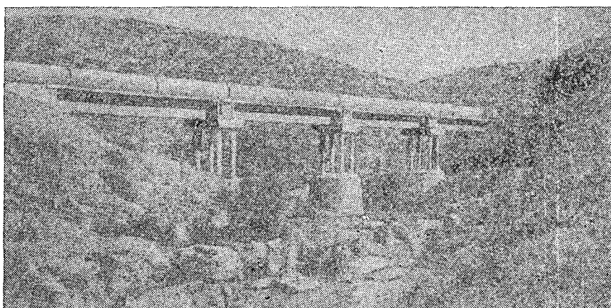
Рис. 136. Железобетонный напорный водовод в ущелье Бу Мессул (Алжир)
