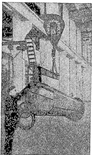
Рис. 196. Съем с навивочного станка готового каркаса спиральной арматуры и транспортировка его в склад мостовым краном
