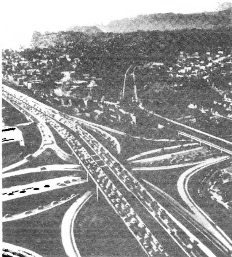
13.19-расм. Чапга бурилишли турдаги тўрт сатҳли кесишиш.
