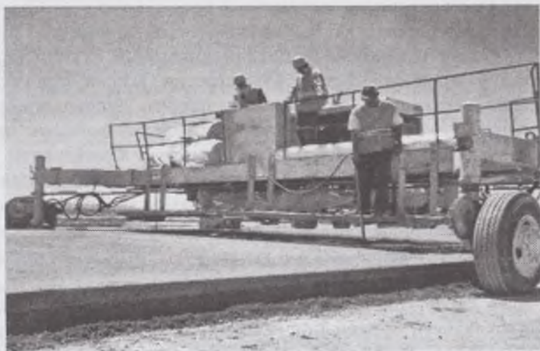
3.5-расм. А-380 автомобиль йўлида PAPINBURG фирмаси цементбетон қопламасини қуриш бўйича технологик жараёнлардан лавҳалар
