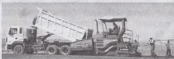
3.11-расм. Иссиқ асфальтбетон қоришмасини йўлга ётқизиш технологик жараёнидан лавҳалар
