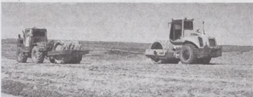
2.9-расм. Муқобил намликдаги грунтни катоклар ёрдамида зичлаш жараёни
