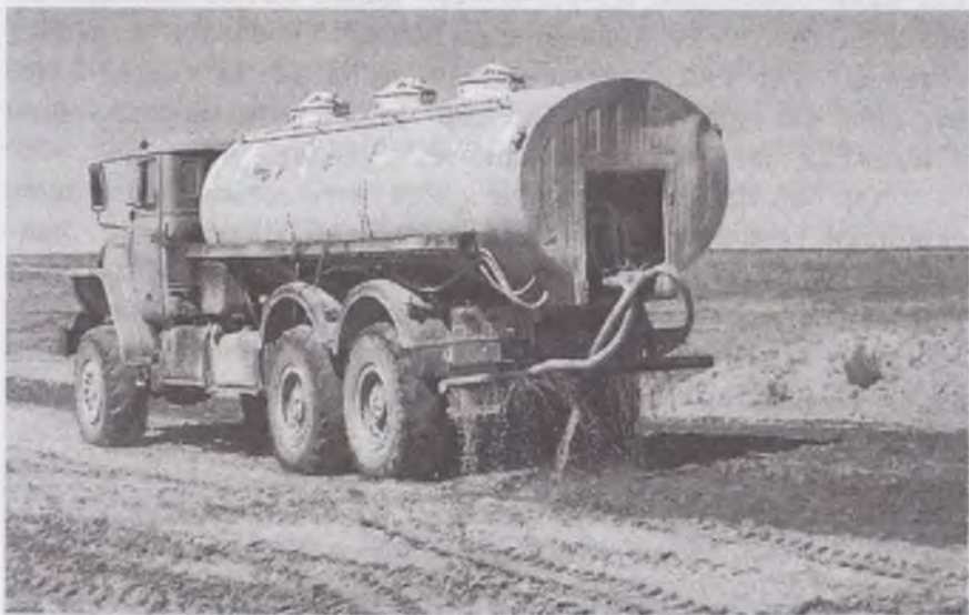
2.8-расм. Грунт намлигини муқобил қийматга етказиш учун сув сепиш жараёни
