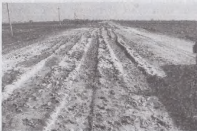
2.66-расм. Шўрхок грунтдан кўтарилган йўл пойи юзасининг кўриниши
