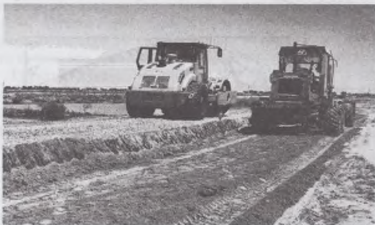
2.30-расм. Йўл пойида грунтларни қатлам-қатлам ёйиш ва зичлаш
