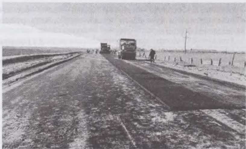
3.14-расм. Мустаҳкамланган йўл асосини қоплама ётқизиб зичлаш
