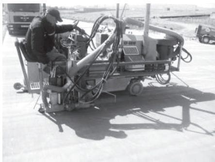
4.30-расм. Кўндаланг ва бўйлама чокларнинг очилиши.
