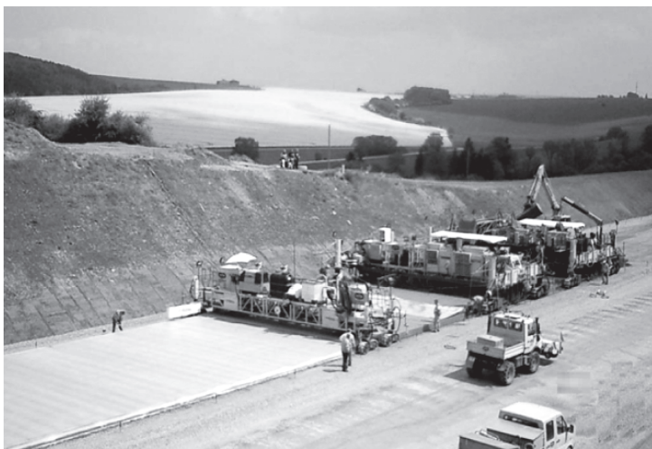
4.10-расм. «Wirtgen» фирмасининг SP-1500 моделидаги бетонётқизгичи.
