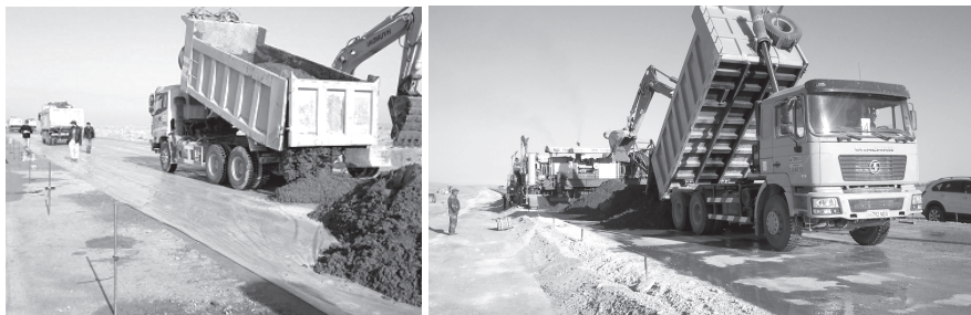
4.15-расм. Ташиб келтирилган бетон қоришмаси.
