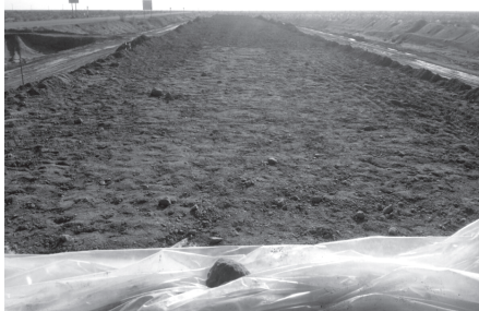
4.24-расм. Юқори ҳароратларда ётқизилган қоплама қарови учун бажариладиган ишлар кетма-кетлиги.
