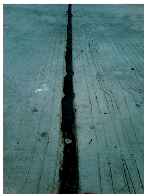
4.36-расм. Иссиқ об-ҳавода сиқилиш чокларидаги мастиканинг қоплама юзасига чиқиб қолиши.
