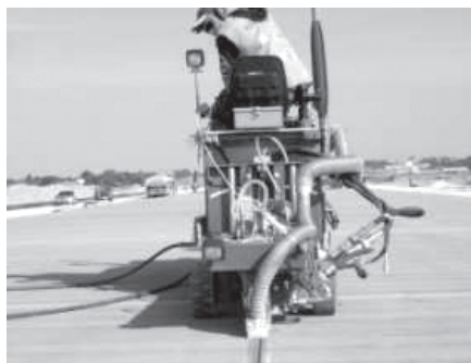
4.30-расм. Кўндаланг ва бўйлама чокларнинг очилиши.
