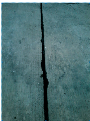
4.36-расм. Иссиқ об-ҳавода сиқилиш чокларидаги мастиканинг қоплама юзасига чиқиб қолиши.
