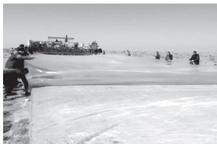
4.24-расм. Юқори ҳароратларда ётқизилган қоплама қарови учун бажариладиган ишлар кетма-кетлиги.
