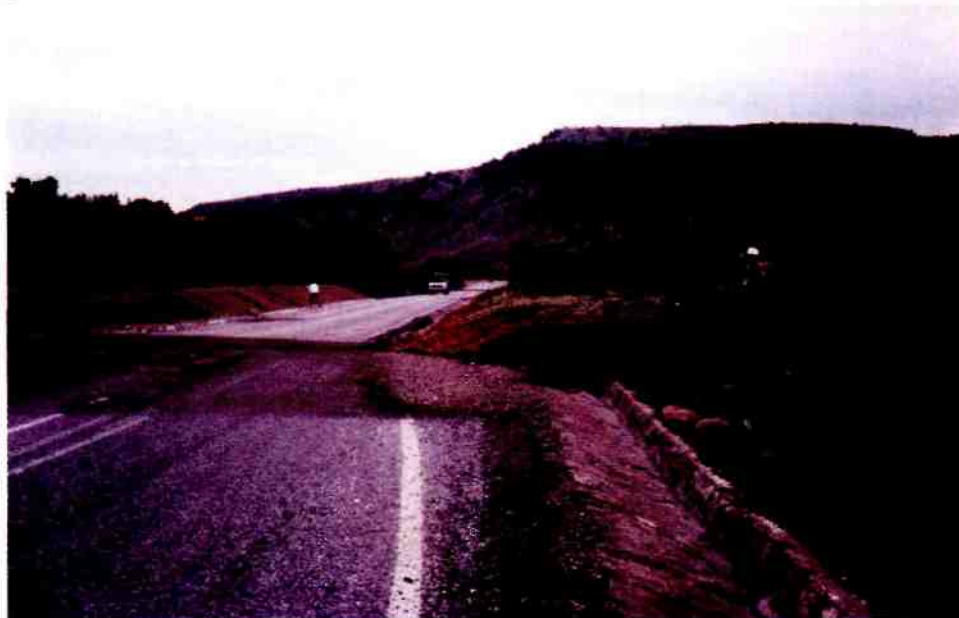
Рис. 40. в — система сбросов в стенке Коринфского канала, Греция (фото Н. В. Короновского); г — левый сдвиг, образовавшийся во время землетрясения в 1989 г., Мексика (фото Н. В. Короновского)
