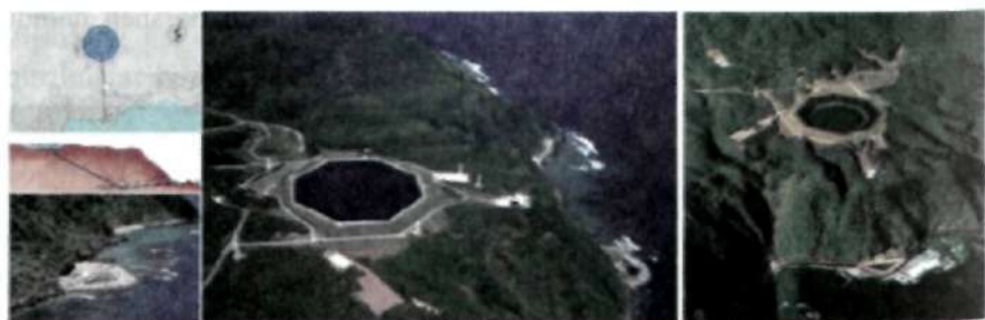
81-rasm. Dengizdan yuqorida joylashgan hajmning suvga to'ldirilishi va suvni qayta tashlab elektr energiyasi olinishi.
