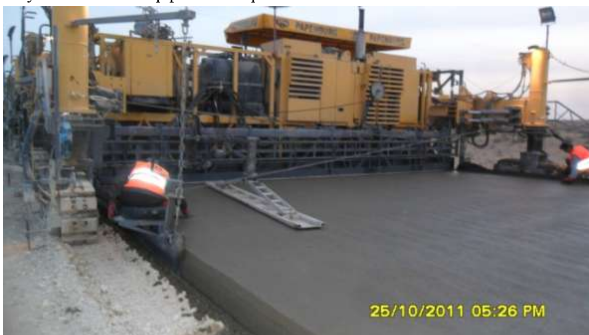
44-rasm. Yo'l to'shamasi qoplamasini qurish
