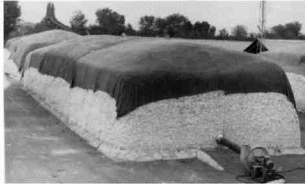
2.8- rasm. Paxtani ochiq g'aram maydonlarida saqlashda havo so'rish qurilmalaridan foydalanish.
