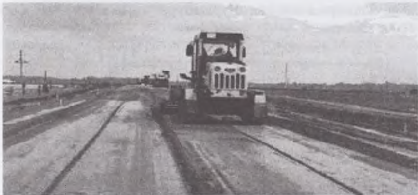
2.51-расм. Йўл пойи юзасини автогрейдер билан пардозлаш
