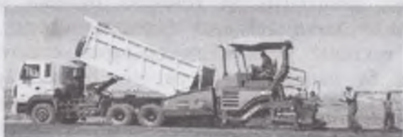
3.11-расм. Иссиқ асфальтбетон қоришмасини йўлга ётқизиш технологик жараёнидан лавҳалар
