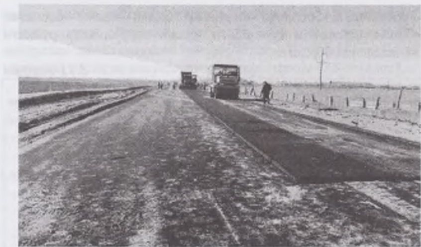
3.14-расм. Мустаҳкамланган йўл асосини қоплама ётқизиб зичлаш
