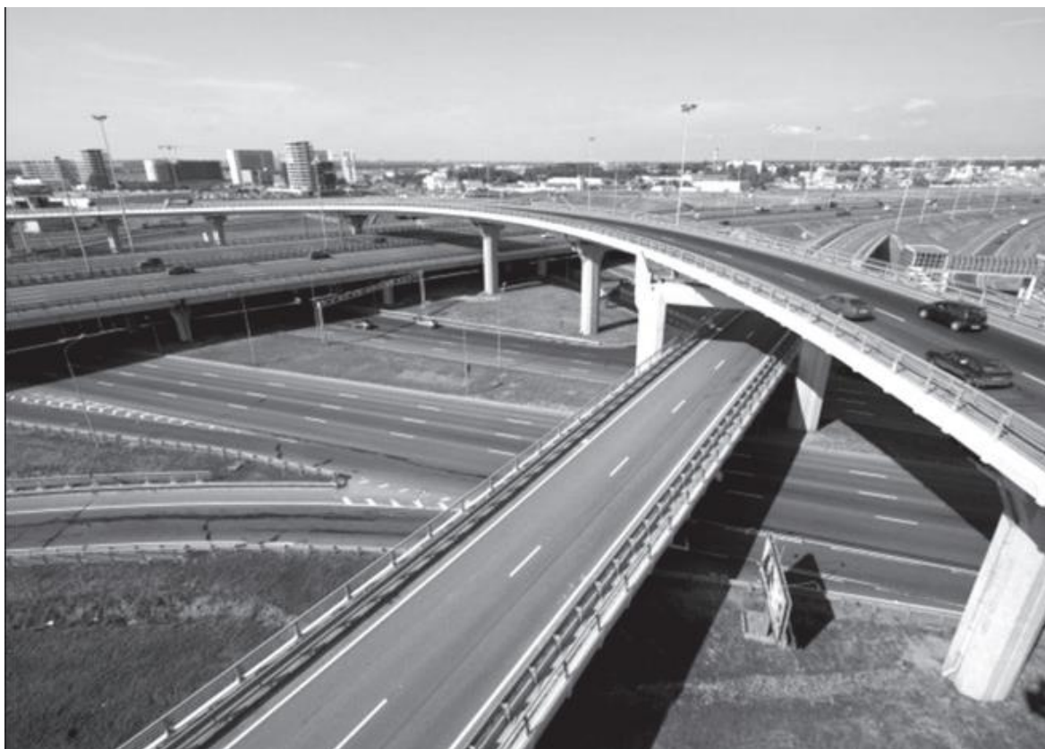
2.2-rasm. Yo‘l o‘tkazgich. Yo‘l o‘tkazgichlarni avtomobil va temir yo‘llar kesishmasida yoki ikki temir yo‘l kesishmasida quriladi.
