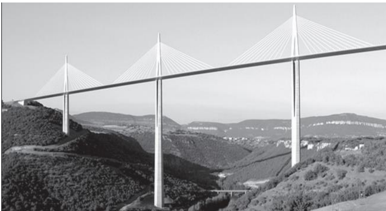
2.3-rasm. Jar ko‘prik (Viaduk) Miyo (le Viaduc de Millau). Viaduc de Millau ning oltita markaziy oraliqlari har biri 342 m uzunlikka ega ,ikkita chetdagisi esa-204 m. Yo‘l poyining yerdan maksimal balandligi-270 m, pilonlarning maksimal balandligi- 343 m.
