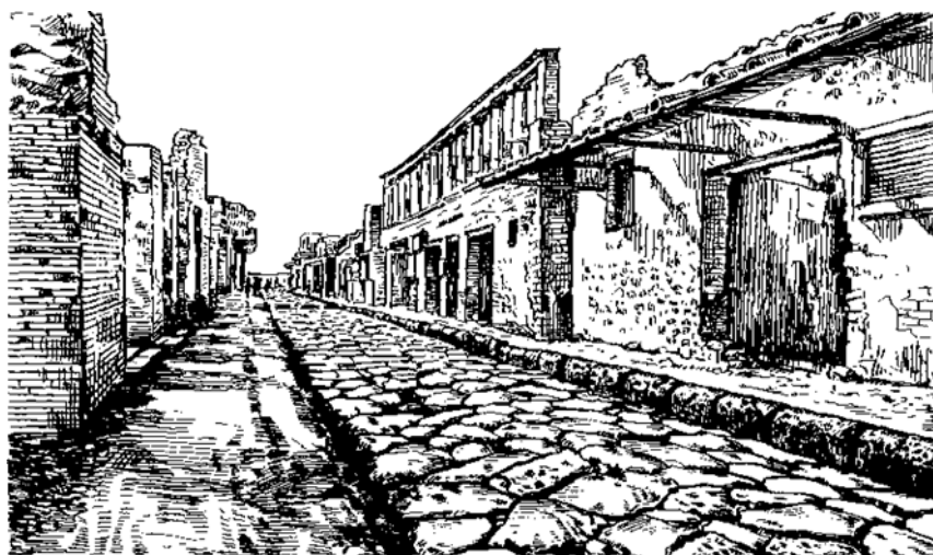
2.3-rasm. Pompe katta tosh bo‘laklaridan qurilgan yo‘l.
