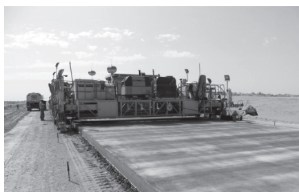
4.29-расм. Қопламаси юзаси ғадир-будир қилиниб, кейин плёнка ҳосил қилувчи моддани пуркаш ишлари автоматик равишда бажарилиши.
