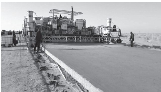
4.9-расм. Бетон қопламасини сирпанувчи қолиплар ёрдамида қуриш технологияси.
