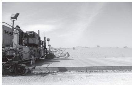
4.29-расм. Қопламаси юзаси ғадир-будир қилиниб, кейин плёнка ҳосил қилувчи моддани пуркаш ишлари автоматик равишда бажарилиши.
