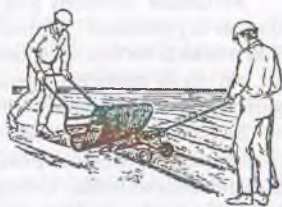
10.1-rasm. Eritiladigan ruberoid asosida tomi gidroizolatsiyalash.
