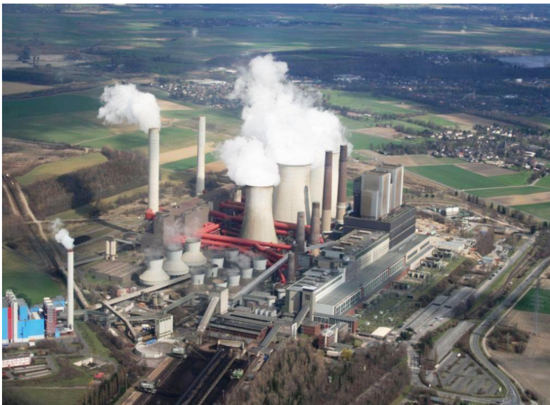
Rasm - 3.1.1. Issiqlik elektr stantsiyasi ko'rinishi.
