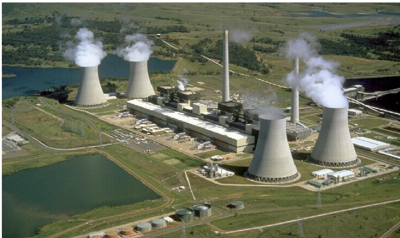
Rasm - 3.1.2. Atom elektr stantsiyasi ko'rinishi.
