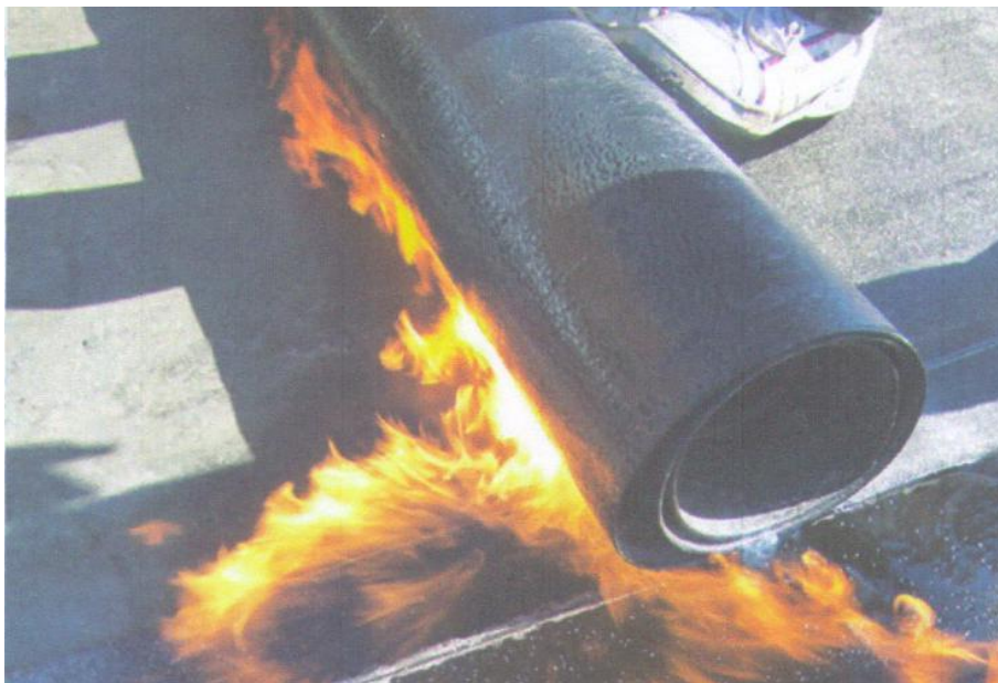
10.1-расм. Томбон рубероид ва уни асосга ёпиштириш
