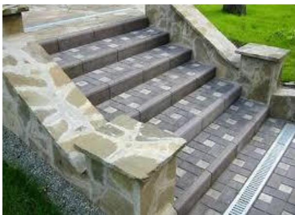
Бетон плиткали зинапоя конструкцияси
