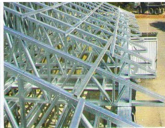
Том фермаси конструкцияси
