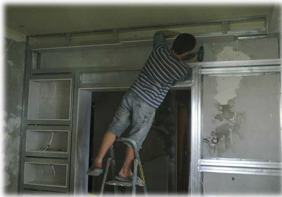
3.13-rasm. Gipskarton listlari asosida pardevorlarni barpo etish
