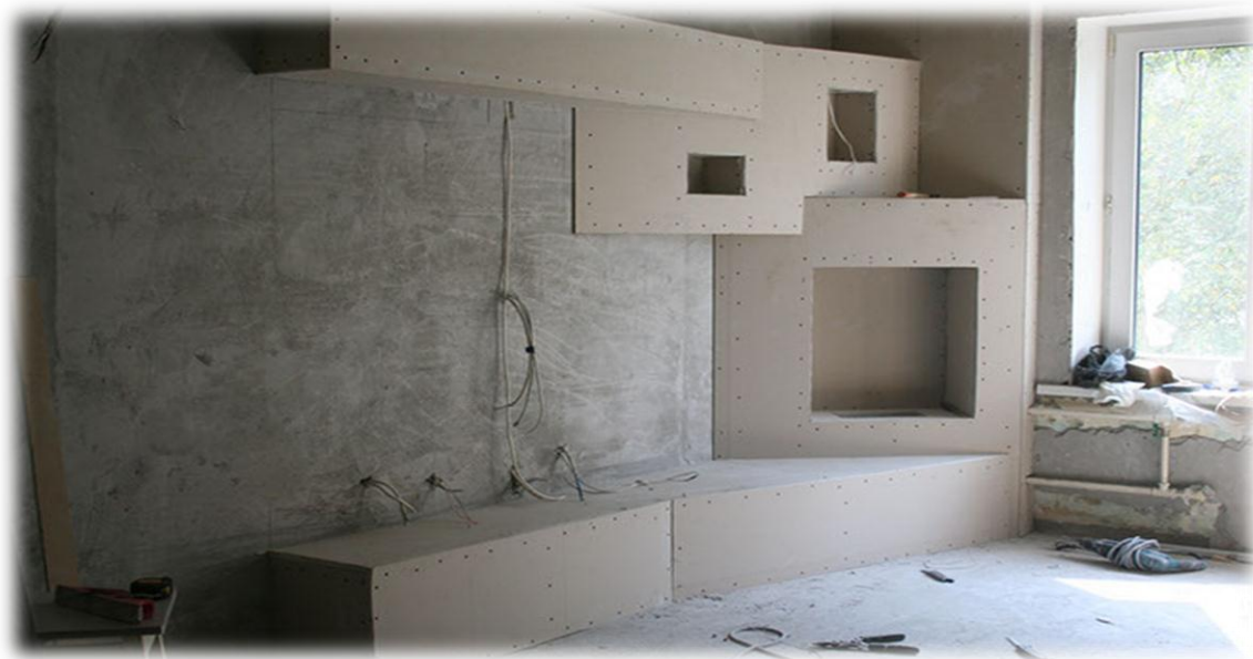
3.14-rasm. Gipskarton listlarni mahkamlash
