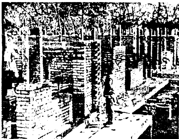
13.18-расм. Темирбетон ўзакли гишт деворнинг кўриниши
