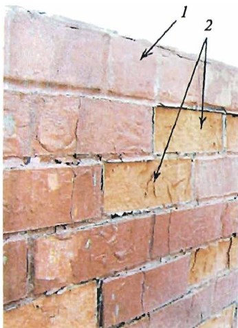
15.1-rasm. Lok-bo'yoq bilan pardoqlangan g'ishtli devor ichkarisidan oqib chiqayotgan issiq bug' suvga aylanib muzlaydi va g'ishtning yuza qatlamini buzadi: 1—lok-bo'yoq pardasi g'ishtning g'ovak-naychalar og'zini berkitib, bug' o'tkazmaydigan qilgan va suv yig'ilgan; 2—qish faslida suvning muzlashi va kengayishi g'ishtni buzgan.
