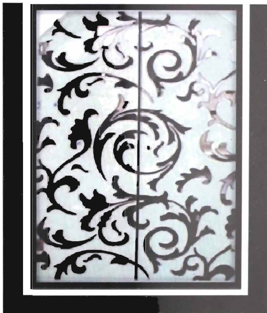
9.11-rasm. Derazabop shisha-taxta yuzasini qum bilan xiralashtirib ishlangan manzarali oyna.
