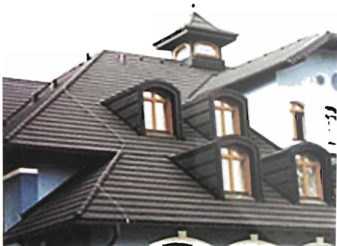
3.6- rasm. Aluminiy, rux va kremniy asosida ishlangan temir cherepitsali tom.
