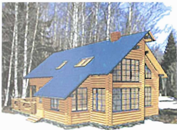
3.8- rasm. Qalinligi 0,4–1,2 mm li ruxlangan, polimer bo‘yoq bilan bo‘yalgan profnastil bilan yopilgan tom.
