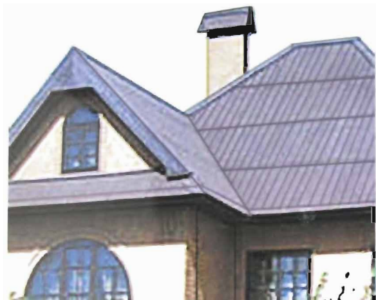
3.7- rasm. Selluloza tolali, qalinligi 2–3 mm li matoni maxsus bitum bilan shimdirib bo‘yalgan tombop to‘lqinli bitum listi.
