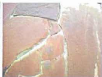
7.4-rasm. Sokol, yerto'la devorlarini qoplashda ishlatiladigan magnezit plitalari.
