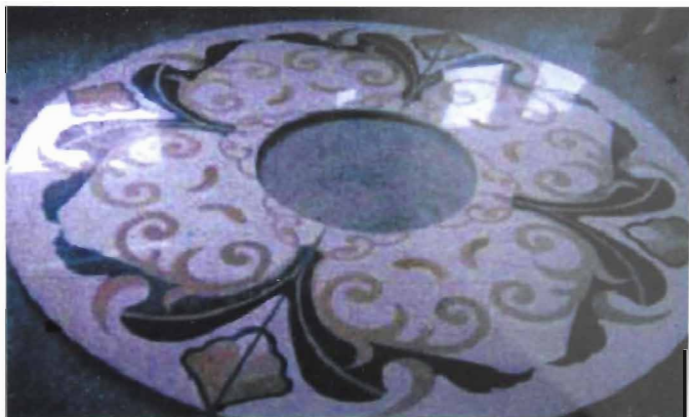
12.10-rasm. Mayda rangli qum va oq sement asosida ishlangan pol kompozitsiyasi.
