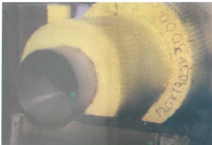
9.15-rasm. Shishapaxtalari bilan harorati 500 °C gacha, diametri 250 mm gacha bo'lgan temir quvurni izolyatsiyalash.
