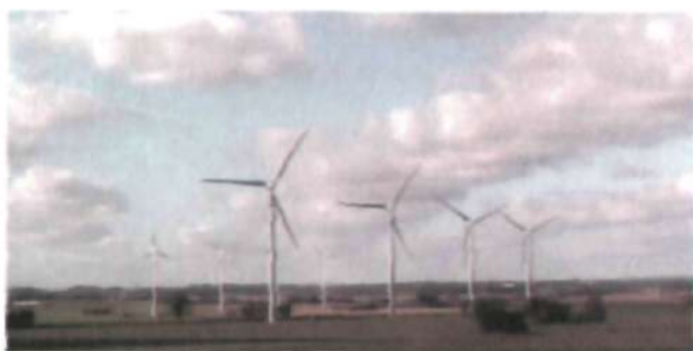
4-rasm. Shamol generator qurilmasi va elektrostansiyasi.
