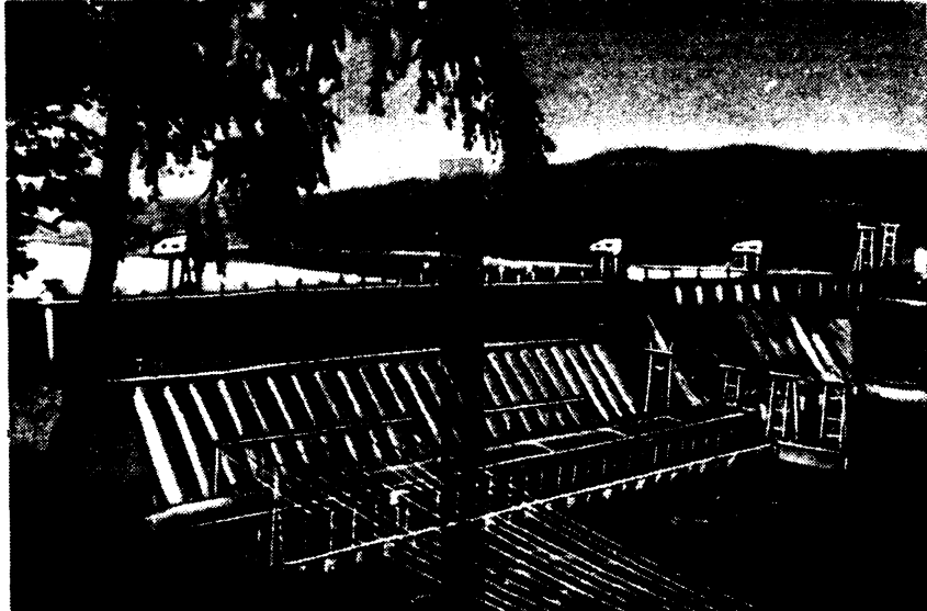
Рис. 5.2. Красноярская ГЭС имени 50-летия СССР — одна из крупнейших в мире. Первые агрегаты ГЭС были пущены в 1967 г. Установлено 12 агрегатов по 600 МВт каждый. Проектная мощность ГЭС 6000 МВт была достигнута в 1971 г.
