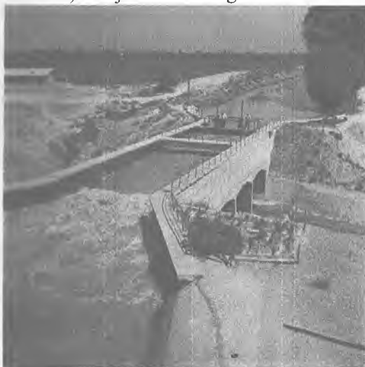
8.14 - rasmi. Shimoliy Farg'ona kanali bilan Janjalsoy kesishgan joydagi akveduk
