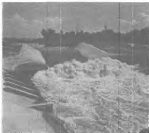
5.13 - rasm. Jun kanali PK 64 + 20 dagi tezoqar – sharshara.
