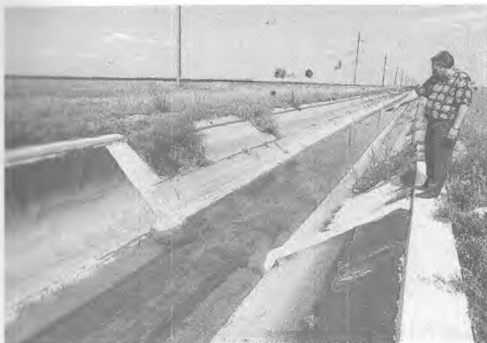
5.3 - rasm. Kanal o'zanida o'sgan suv o'tlarni paydo bo'lishi
