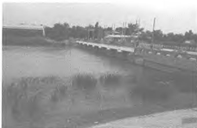
5.5 - rasm. Janubiy Mirzacho'l kanalining PK 145 dagi gidrouzelni yuqori b'efi o'zanida o'sgan suv o'tlari
