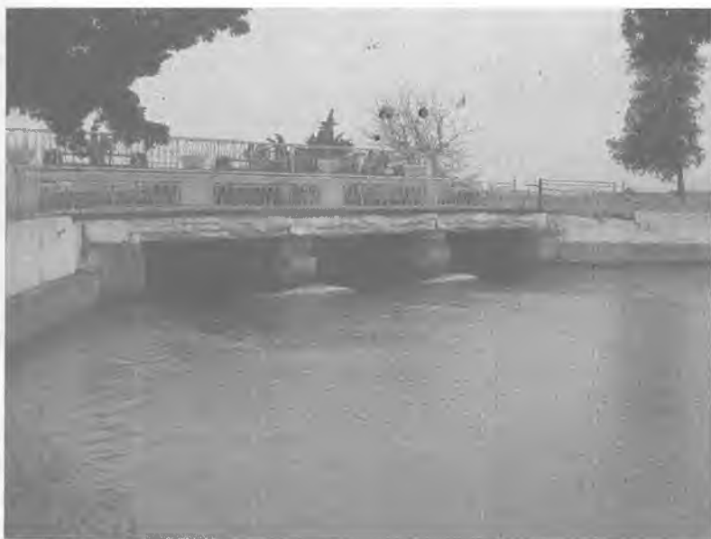
3.4 - rasm. Do'stlik kanali PK 460 da joylashgan gidrouzel oraliq ustunlarining yemirilish holati
