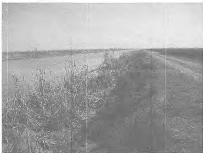
5.2 - rasm. Kanal qirg‘og‘ini o‘t bosish holati
