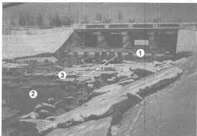
13.17 - rasm. Chap qirg'oq Qorasuv kanali 9+20 piketidagi suv taqsimlash inshootining Qorasuv daryosiga suv tashlamasi pastki befini ko'inishi: 1 - pirslar; 2 - yuvilish daganagi; 3 - fundament bloklari.
