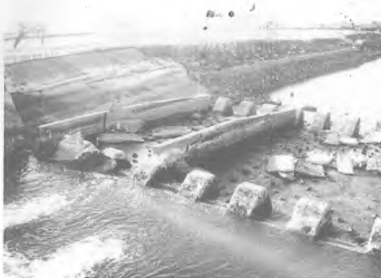
3.2 - rasm. Do'stlik kanalining PK 580 da joylashgan tashlama, inshootni pastki befidagi abraziv yemirilishlar.
