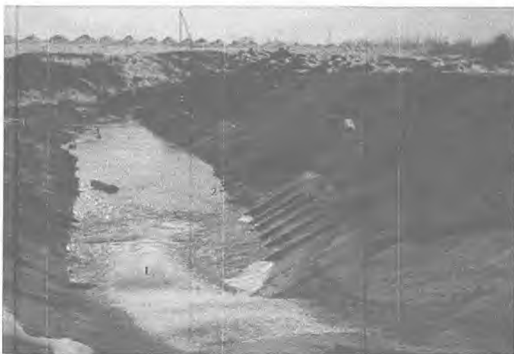
8.4 - rasm. Ta'mirlashdan so'ng g'adir-budurli perepad pastki befida qolib ketgan beton bo'lagi (1) va uning ta'sirida qiyshaygan oqim hosil bo'lishi jarayoni, hamda qiyshagan oqim urilib ochilib qolgan risberma uchastkasi (2) va suv olib ketuvchi kanalni yuvilgan uchastkasi (3) (10.01.2007 y.).
