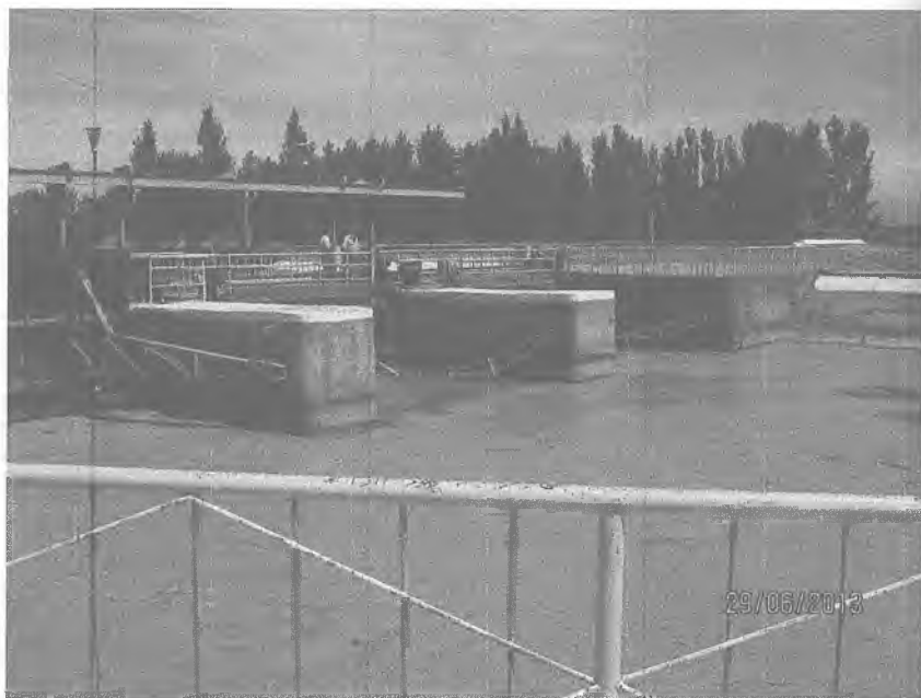
8.6 - rasm Katta Farg'ona kanaliga o'rnatilgan segmentli zatvorlarni pastki befdan ko'rinishi.
