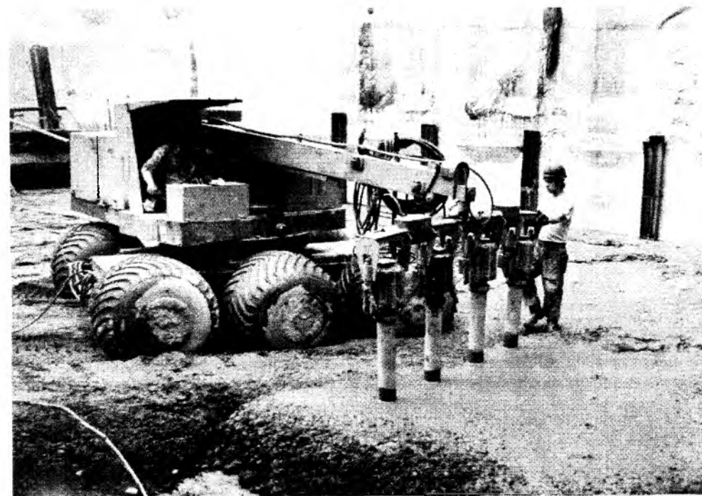
Рис. 8.6 Специальный манипулятор на пневмоходу с пакетом вибраторов в блоке бетонирования плотины Саяно-Шушенской ГЭС
