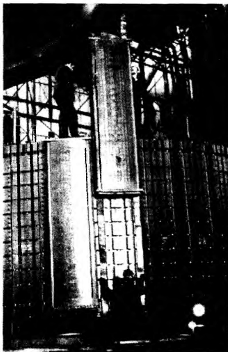
Рис. 8.16 Установка полюсов на обод ротора генератора Саяно-Шушенской ГЭС
