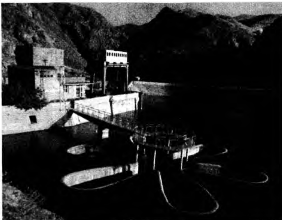
Рис. 4.10 Шахтный водосброс «Маргаритка» на деривационной Татевской ГЭС
