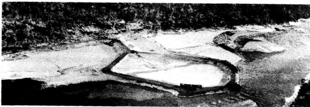
Рис. 8.1 Перемычный способ последовательности возведения гидроузла. Часть правобережного котлована (первая очередь) под строительство водосбросной плотины Саяно-Шушенской ГЭС
