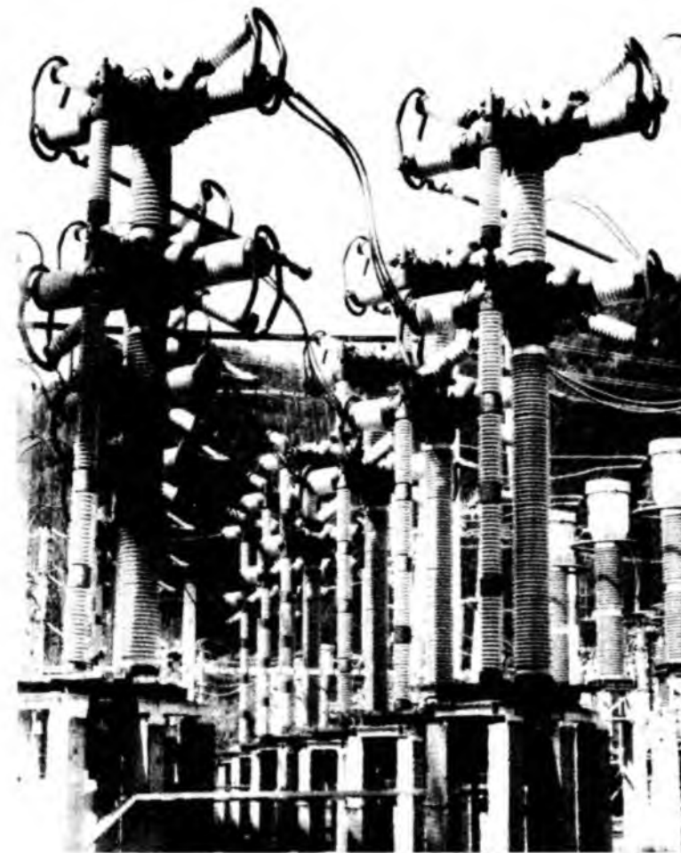
Рис. 6.23 Воздушные выключатели типа ВВБК-500А арктического исполнения на ОРУ-500 кВ Саяно-Шушенской ГЭС
