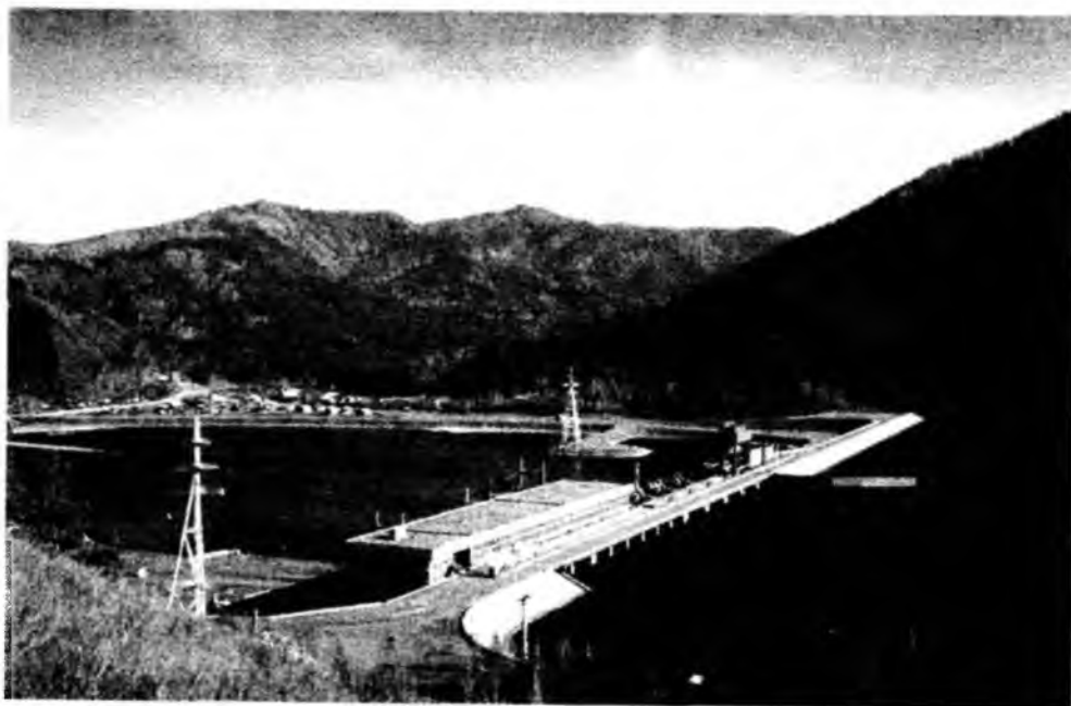
Рис. 2.6 Внешний вид русловой низконапорной Майнской ГЭС на р. Енисей
