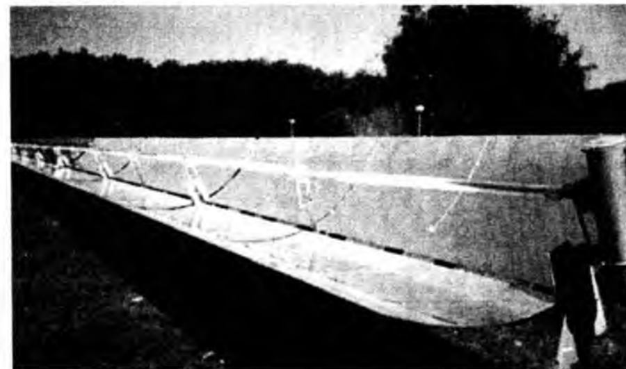
Рис. 2.14 Солнечная электростанция с параболическими концентраторами
