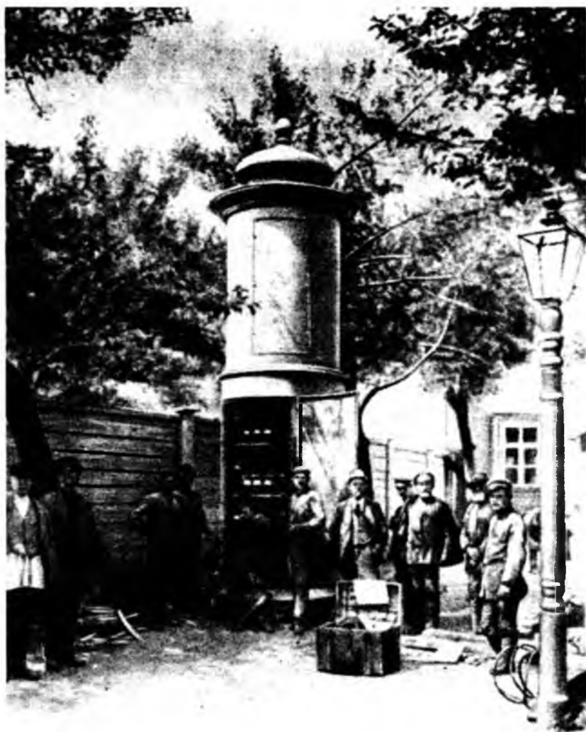
Рис. 1.15 Двухэтажная трансформаторная подстанция в кабельных сетях России
