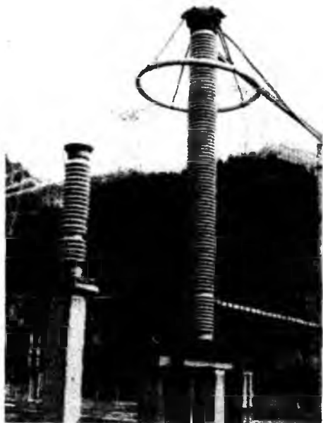
Рис. 6.35 ОПНИ, установленный на ОРУ-500 кВ Саяно-Шушенской ГЭС
