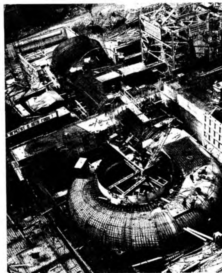
Рис. 5.9 Внешний вид спиральной камеры Саяно-Шушенской ГЭС в период монтажа
