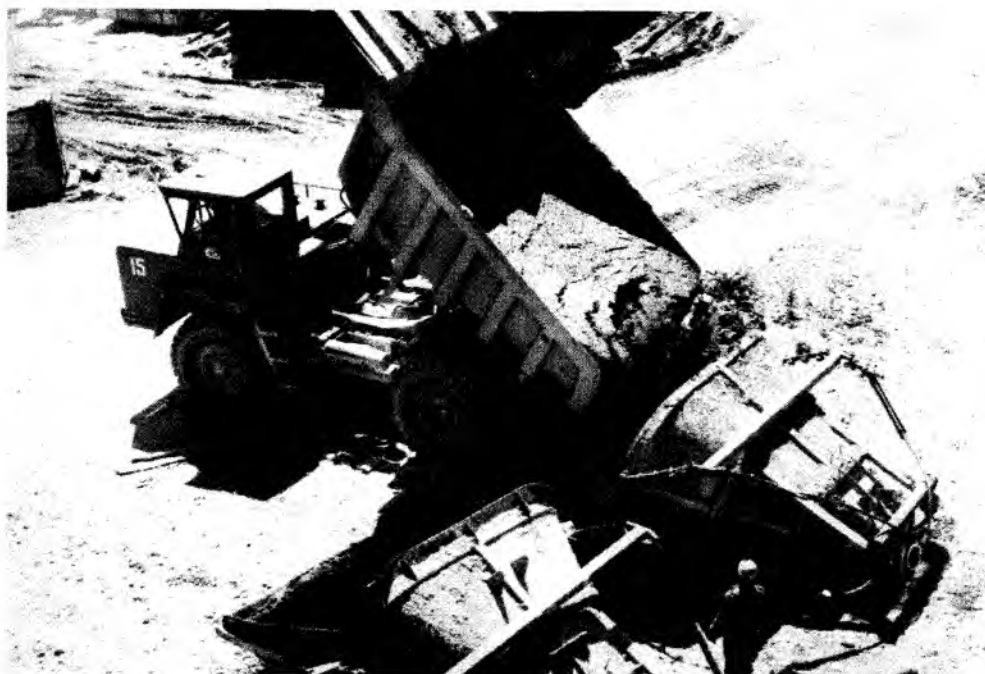
Рис. 8.5 Автосамосвал БелАЗ грузоподъемностью 25 т и бадья 8 м 3 на строительстве плотины Саяно-Шушенской ГЭС
