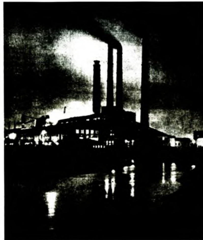
Рис. 1.7 Внешний вид тепловой электростанции
