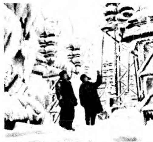
Рис. 9.30 Внешний вид ОРУ после образования снежного покрова
