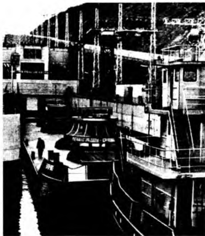
Рис. 7.29 Доставка неразрезных рабочих колес турбин и ванн подпятников генераторов Саяно-Шушенской ГЭС водным путём. Вид на баржу с колесом и ванной, входящую в камеру судоподъёмника на плотине Красноярской ГЭС
