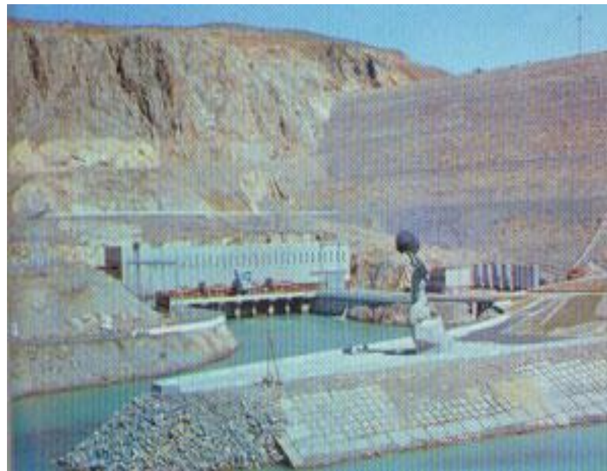
4 – rasm. Chorvoq GESi. (Nabori H=148,0 m, quvvati N=600 MVt, 1970 yil ishga tushirilgan)
