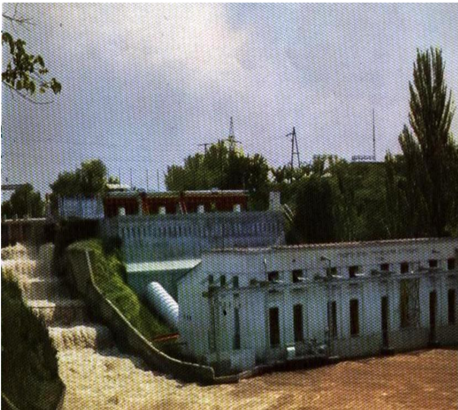
1-rasm. Bo'z-suv GESi. (Nabori H=13,5 m, quvvati N=4 MVt, 1926 yil ishga tushirilgan)
