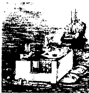
3.36-rasm. Qurilish dokida qurilgan ko'tariluvchi suv elektr stansiyasi binosini Kislogubskka o'rnatish uchun suvda shatakka olib borish.
