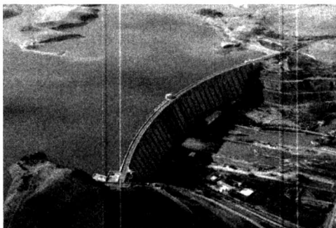
3.36 – rasm. Andijon suv omborining kontrforsli to‘g‘oni.
