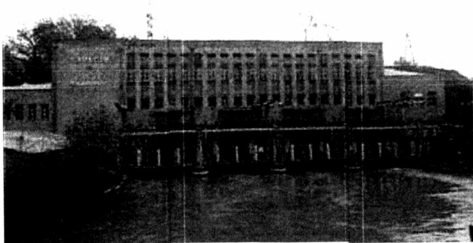
1.2 – rasm. Qodiriya gidroelektr stansiyasi. Quyi b'ef tomonidan ko'rinishi.
