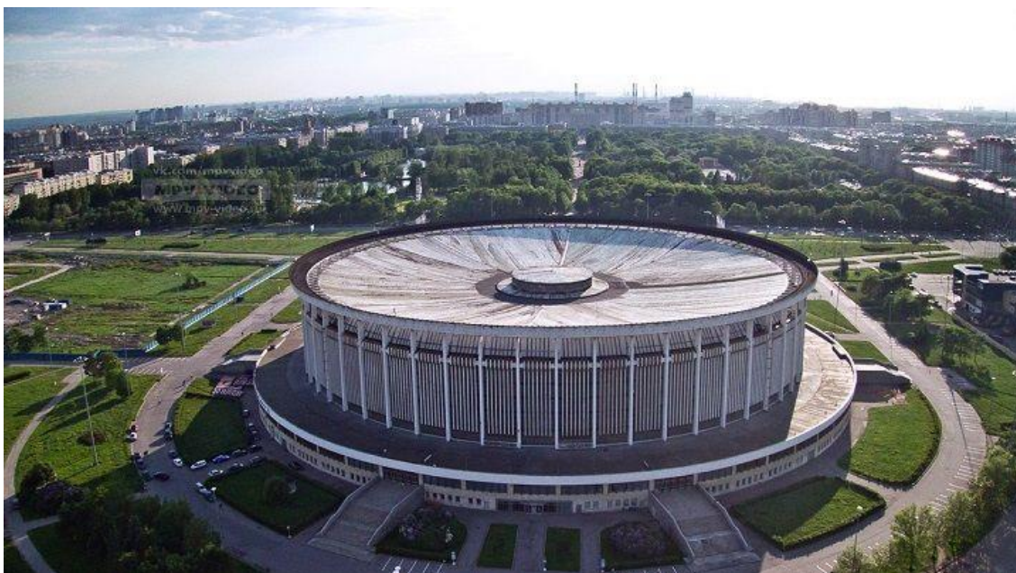
16.4 – расм. Икки белбоғли вантли система Санкт – Петербургдаги «Юбилейный» спорт саройни том ёпма конструкцияси.
