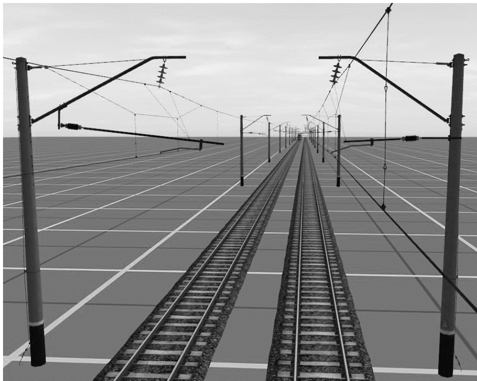
6.49- rasm. Kontakt tarmog'ining ajratilgan temirbeton tayanchlari.
