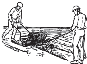
10.1-rasm. Eritiladigan ruberoid asosida tomni gidroizolatsiyalash.
