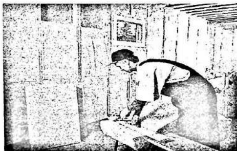
14.1-rasm. Binoni ichkaridan issiqlik izolatsiyasi materiallari bilan qoplash.
