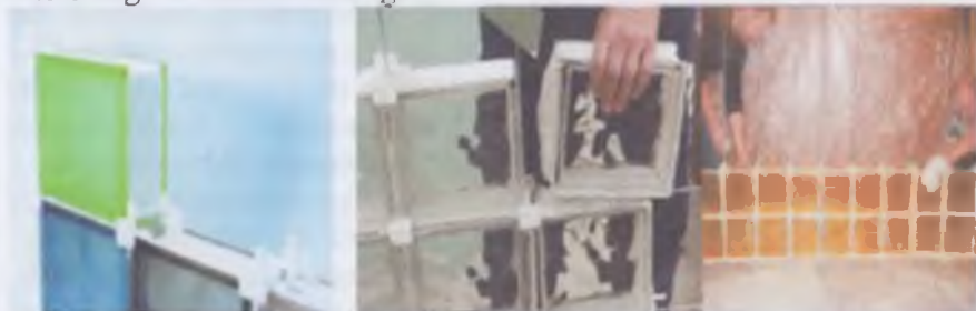
20-rasm. Shishabloklarni terish
