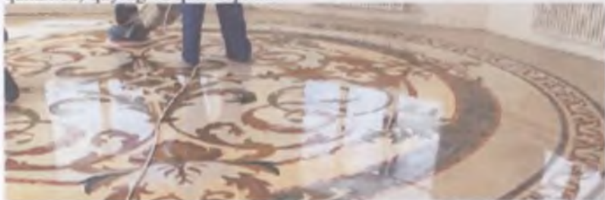
71-rasm. Mozaikali polni pardoqlash jarayoni
