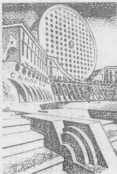
8.3-rasm. Fransiyaning Marn-la-Valle shahridagi quyma betondan qurilgan turarjoy binosi.
